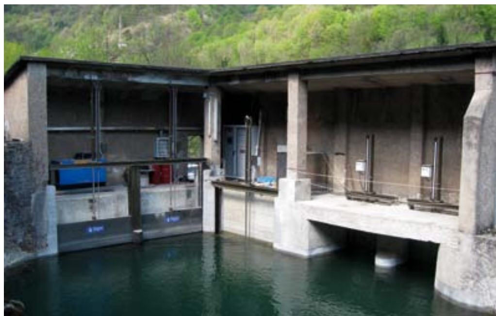
Rifacimento impianto idroelettrico di Mese (SO)
