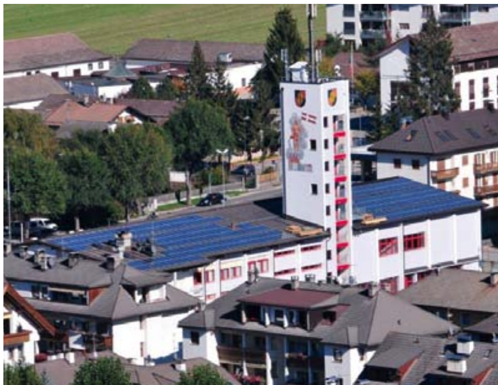
Impianto fotovoltaico integrato sul tetto della caserma dei Vigili del Fuoco di Brunico (BZ)
