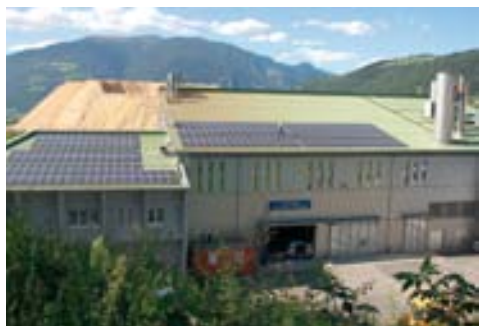
Impianto a biomassa del Comune di Brunico con pannelli fotovoltaici sulla copertura
