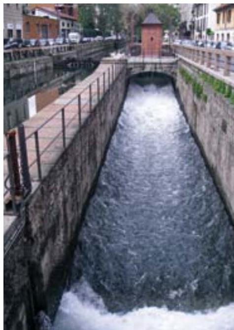
Impianto mini idroelettrico nel Comune di Milano
