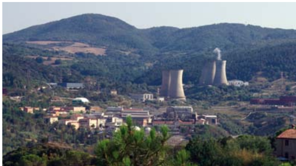
Impianto ad alta entalpia di Larderello nel Comune di Pomarance (PI)
