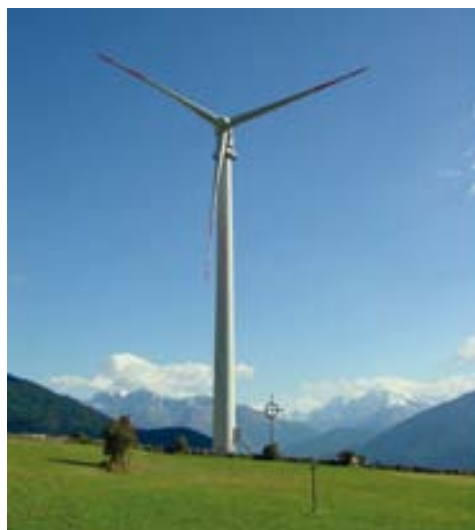
Impianto eolico nel Comune di Sluderno (BZ)
