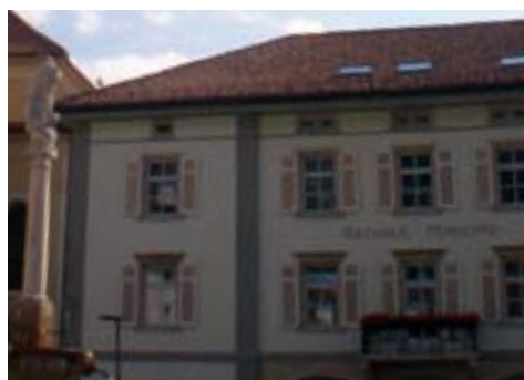
Municipio di Caldaro sulla Strada del Vino (BZ) teleriscaldato da biomasse locali
