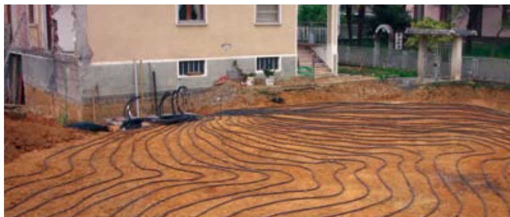
Geotermia a bassa entalpia nel Comune di Fiano (TO)
