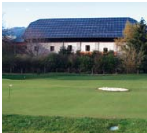
Tetto fotovoltaico su edificio rurale in Provincia di Bolzano
