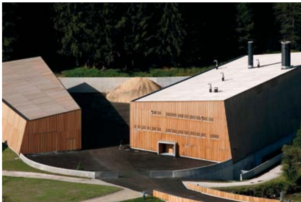
Impianto di teleriscaldamento nel Comune di Sesto (BZ)
