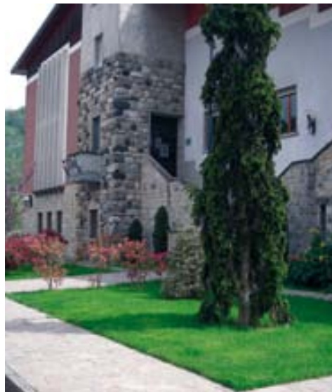
Edificio riscaldato con micro rete di teleriscaldamento nel Comune di Farini (PC)
