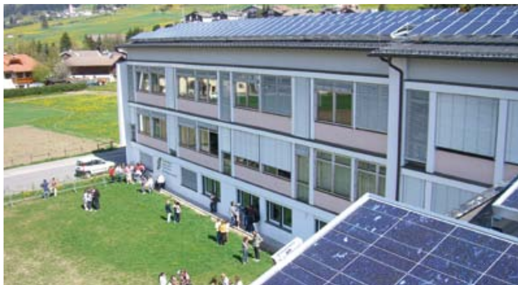
Impianto fotovoltaico scuola elementare Comune di Dobbiaco (BZ)
