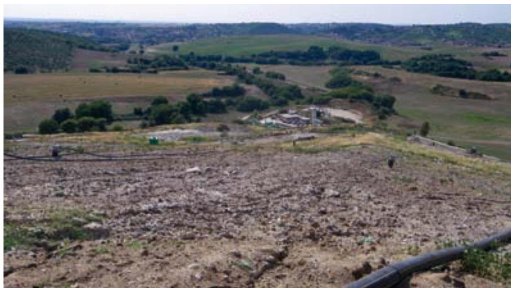
Pozzi di captazione su discarica per impianto a biogas
