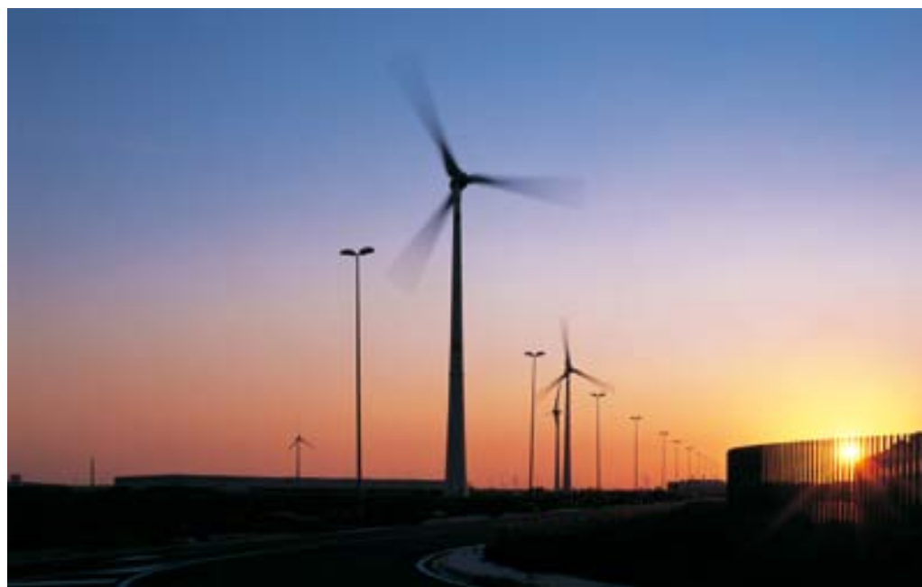
Parco eolico di Pontedera (PI)
