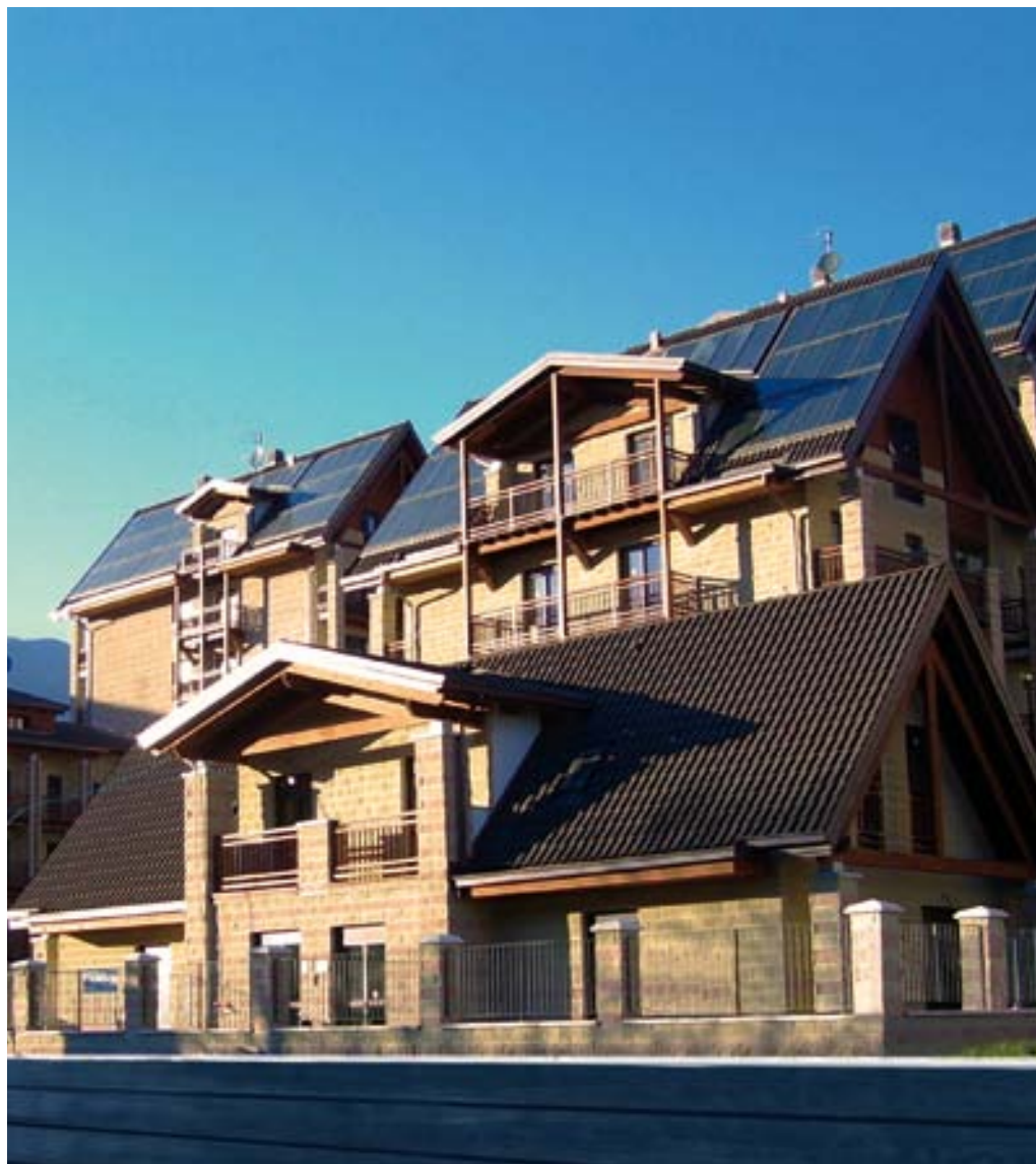
Impianto solare termico integrato da 320 m 2 ad Aosta
