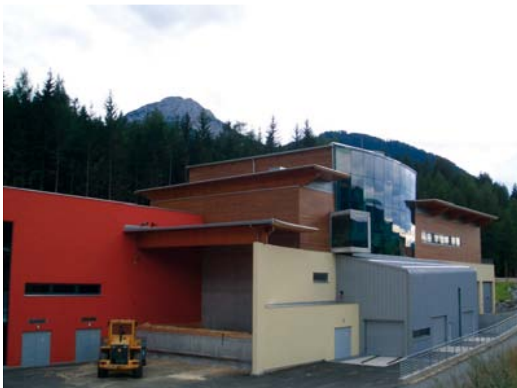
Impianto a biomassa del Comune di Dobbiaco (BZ)
